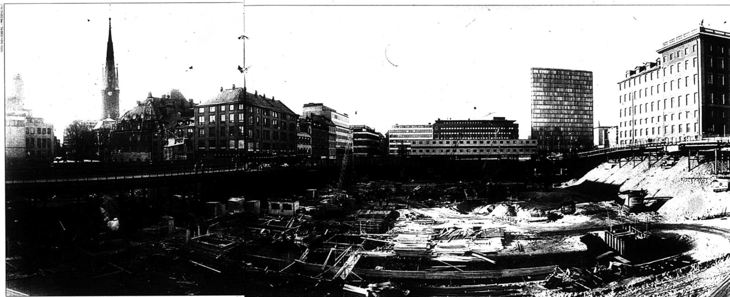
Rivning pågår. Året var 1969 och i den riksrekanta gruppen i Stockholm lades grunden till Sergels torg och Kulturhuset.
